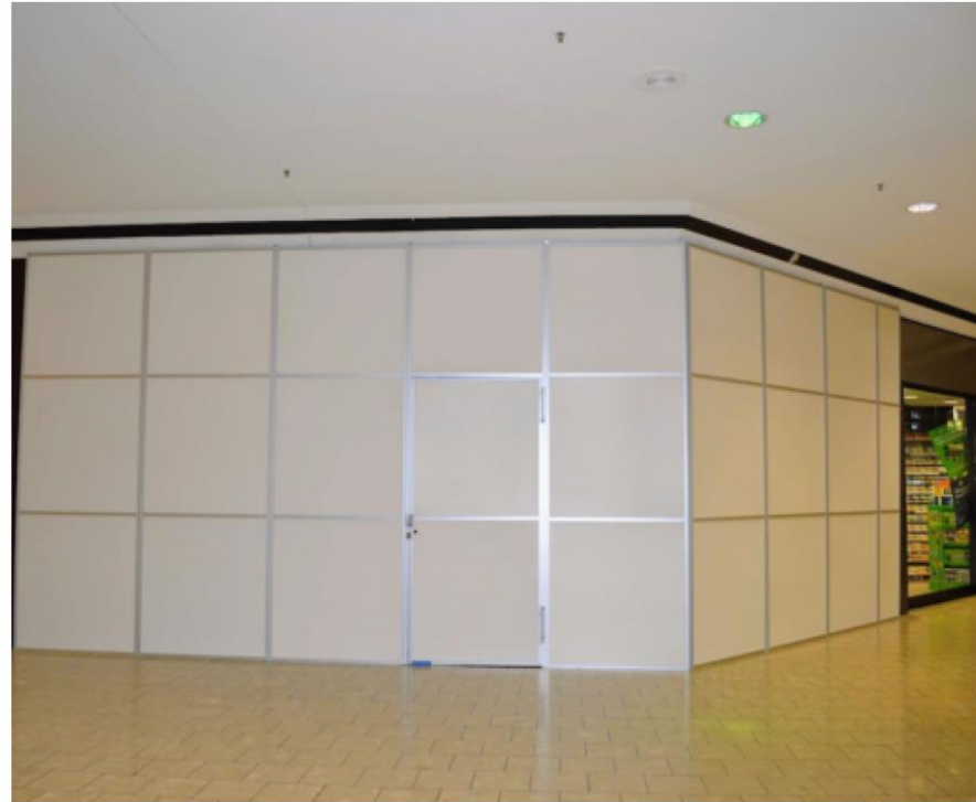
Example of Temporary Partition during construction / Ejemplo del tabique temporal durante la construcción
